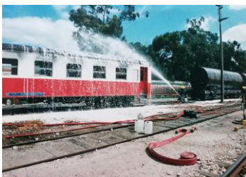
Isolamento de carruagem e vag o cisterna
