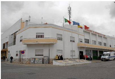
Quartel-Sede AHB Pinhal Novo
