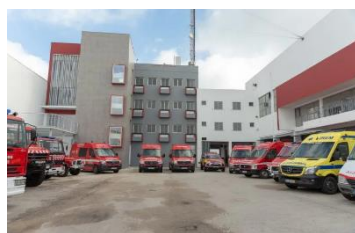
Vista geral do quartel-sede
